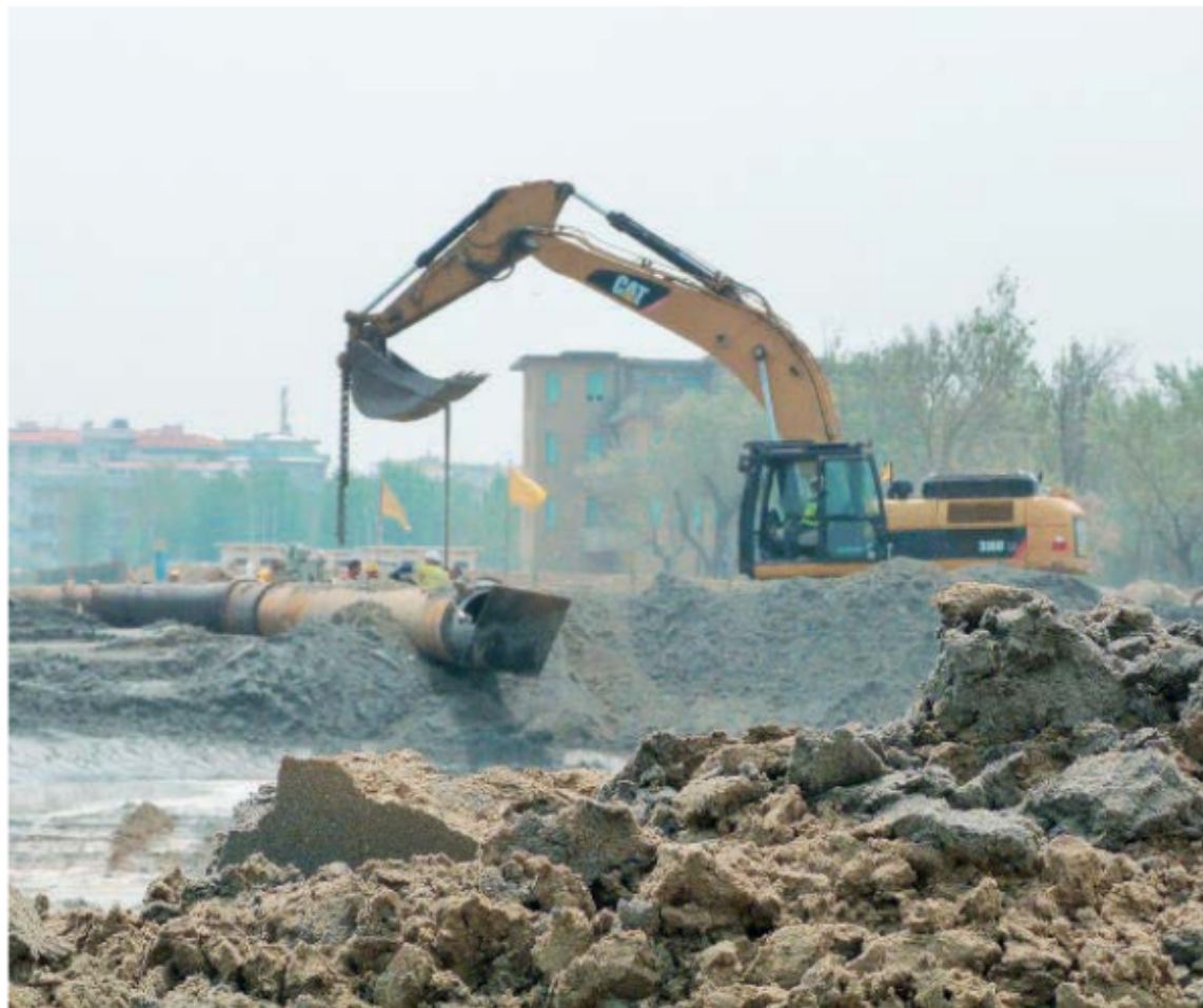
Operazione di ripascimento con le “sabbie relitte”, a Cesenatico, durante uno dei “Progettone” del passato
